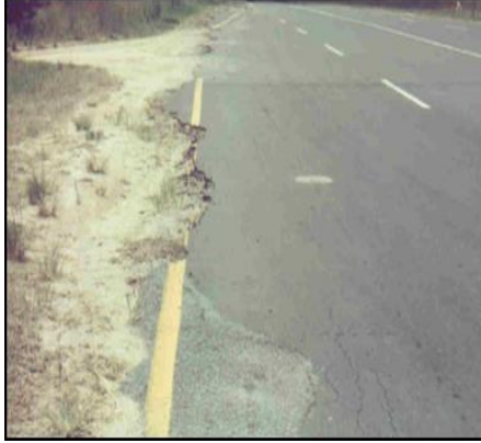
الشكل (4) التشققات الجانبية وموقعها في الطريق
