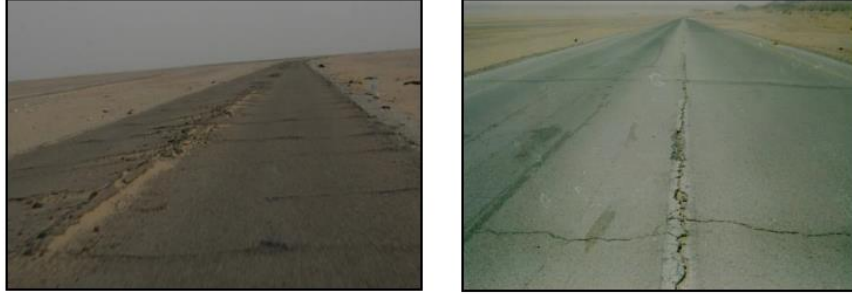
الشكل (3) التشققات الطولية والعرضية
