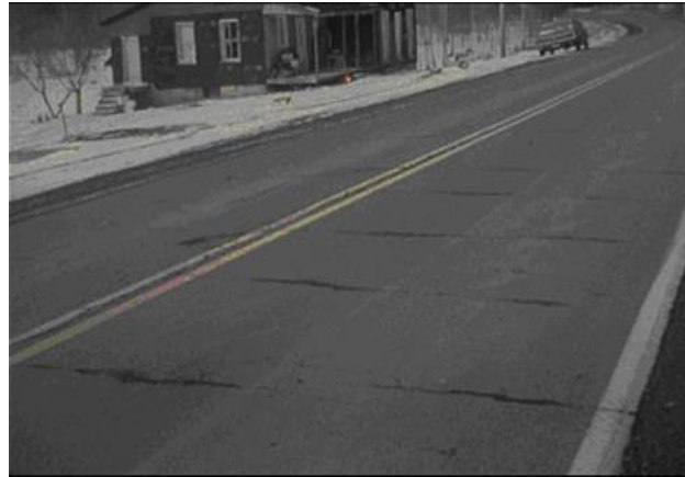
الشكل (5) التشققات الانعكاسية [3]
