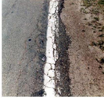
الشكل (4) التشققات الجانبية وموقعها في الطريق
