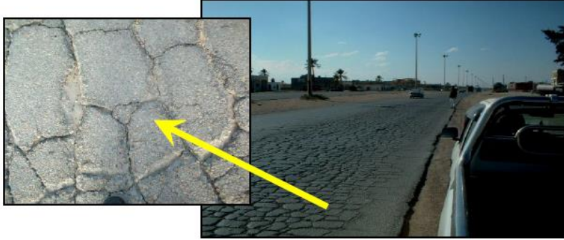
الشكل (1) التشققات التماسحبية وموقعها من الطريق
